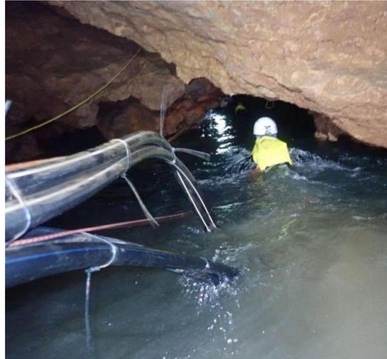
Au début timidement par peur d'une défaillance du système. Nous constatons que la gaine de dérivation est très mal en point, des jets d'eau sortent sous pression, ça fuit de partout... Ces gaines électriques ne sont pas adaptées et seront ressorties découpées en morceaux par la suite.
