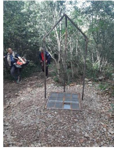
La partie inférieure de la trémie de St Thomé a elle aussi fait l'objet d'une mise aux normes. Pose et scellement de poutres type IPN et soudure d'une multitude de morceaux de fer.
